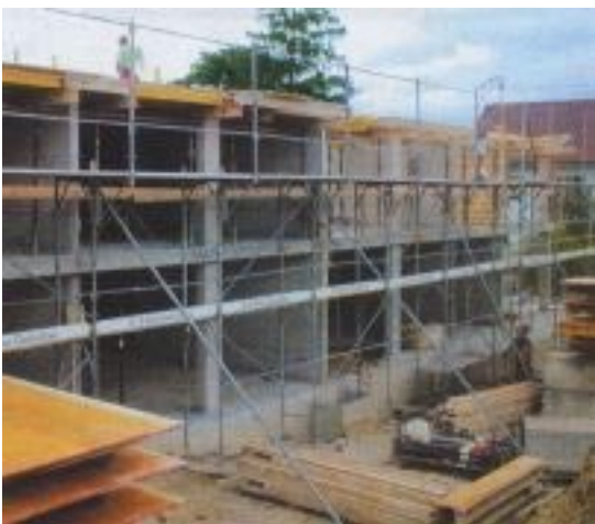
... und Montage des Fassadengerüsts
