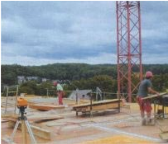
Bau des 1. MINERGIE-MFH in der Region Basel Deckenschalung...
